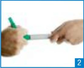
**2. Calibre** el tubo, (no es necesario biselar o escañar; el empleo de juntas de sección rectangular permite obviar esta ejecución).
